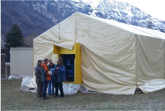
Diskussion zwischen K. Steiner, J. Marti, W. Fischli und F. Tschümperlin vor dem Abluftaustritt mit Schallschutzwänden
