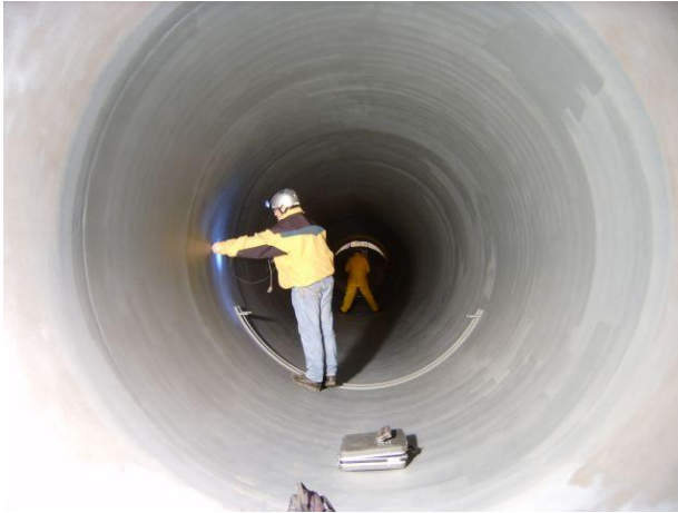
Leitung vor der Drosselklappe im Jahre 2007 saniert
